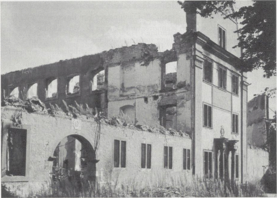
Das zerstörte Schulgebäude
